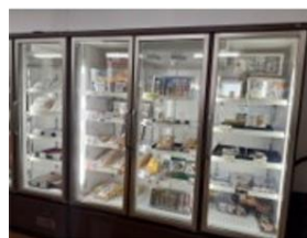
老朽化した冷蔵庫の入替え
